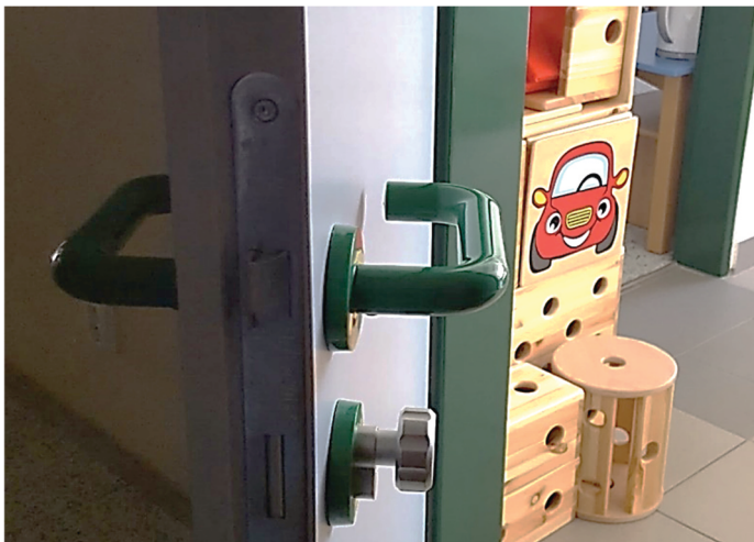
Obrázek 10: Dveře do třídy (vločky s knoflíkem) dle ČSN 73 4400 sloužící k uzamčení žáků před útočníkem. Zdroj: Asociace bezpečná škola
